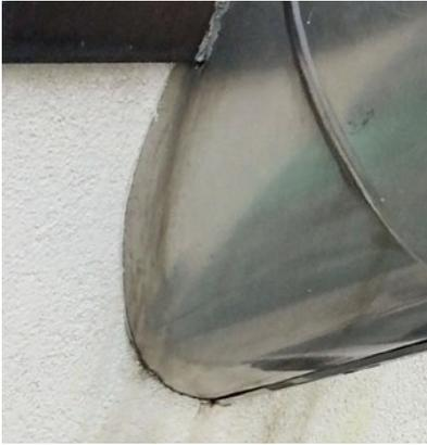
**Bild 1** Schadensbild kein Abweisblech montiert
