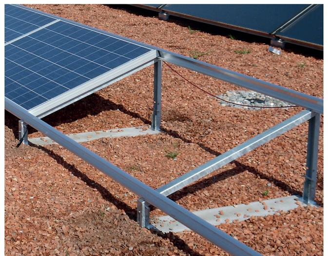
Einbau der Flachdachaufständerung auf einer Druckverteilungsplatte (Betonsockel)
