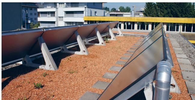
Sonnenkollektoren auf Betonaufständung montiert. Gehwegplatten schützen das Abdichtungssystem bei Wartungs- und Unterhaltsarbeiten an den Modulen.
