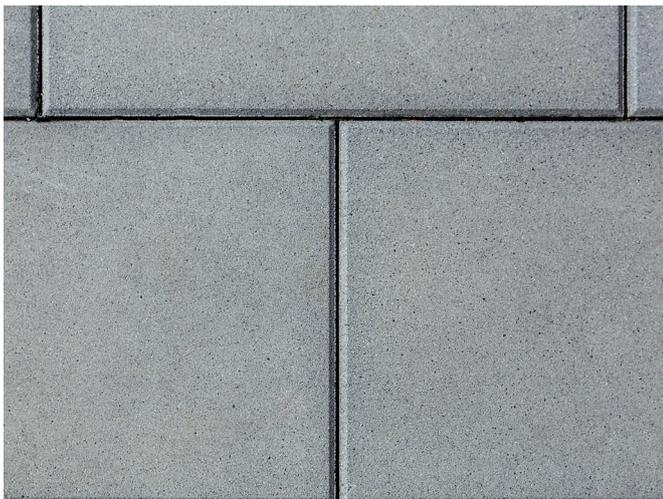
Abb. 9: Betonplatten mit gefasteten Kanten
