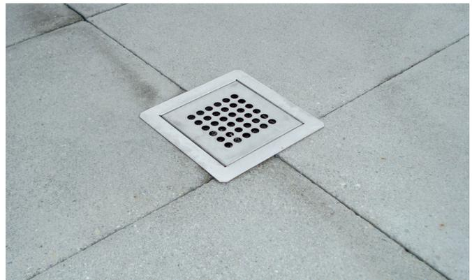
Abb. 17: Dachwassereinlauf: Lochrost
