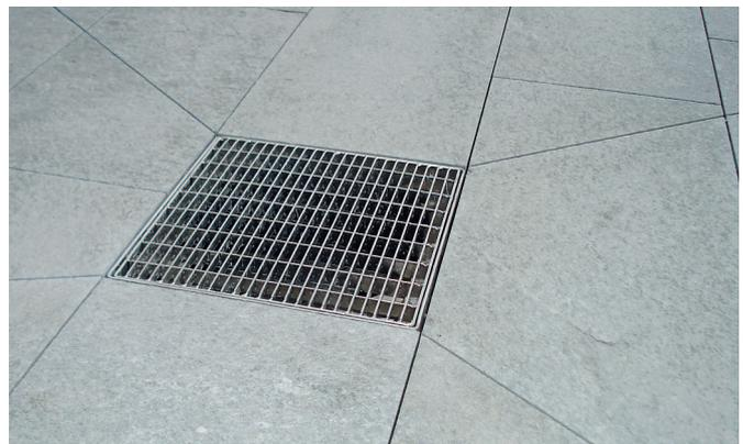
Abb. 16: Dachwassereinlauf: Gitterrost
